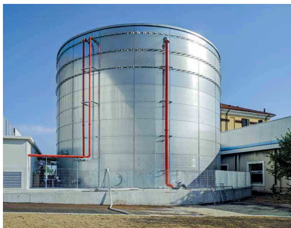
Esempio di vasca realizzata 1
