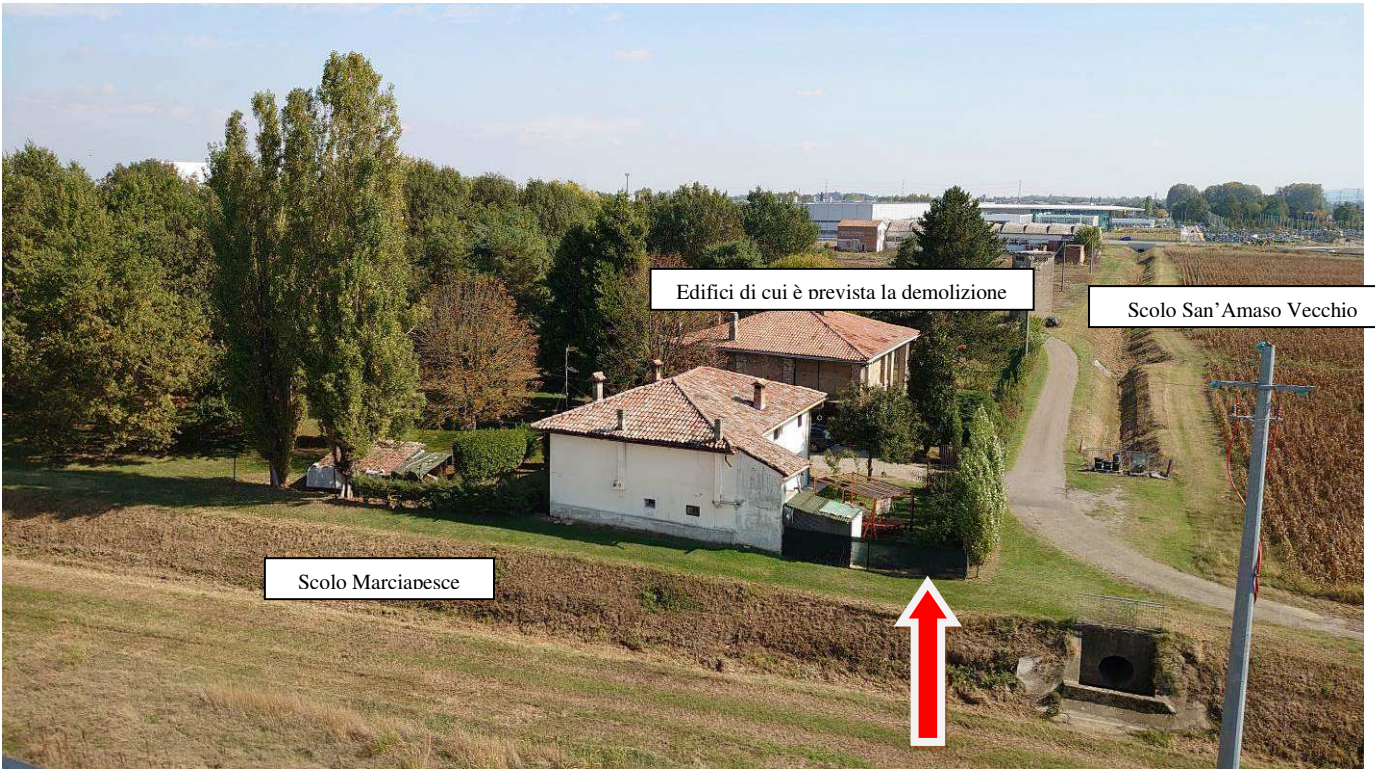
Figura 1 lo spigolo sud ovest con il punto di possibile esondazione dello scolo Marcianese.
